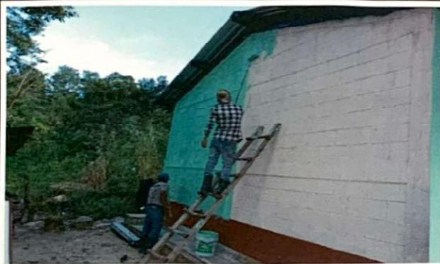
Foto 3: Proceso de pintura de muros interior y exterior.
