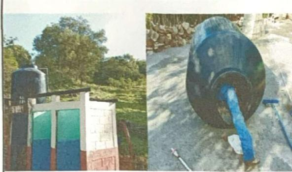
Foto 5: Proceso de reparación de servicios sanitarios y cambio de accesorios, lava manos, Rotoplast y Tubería PVC
